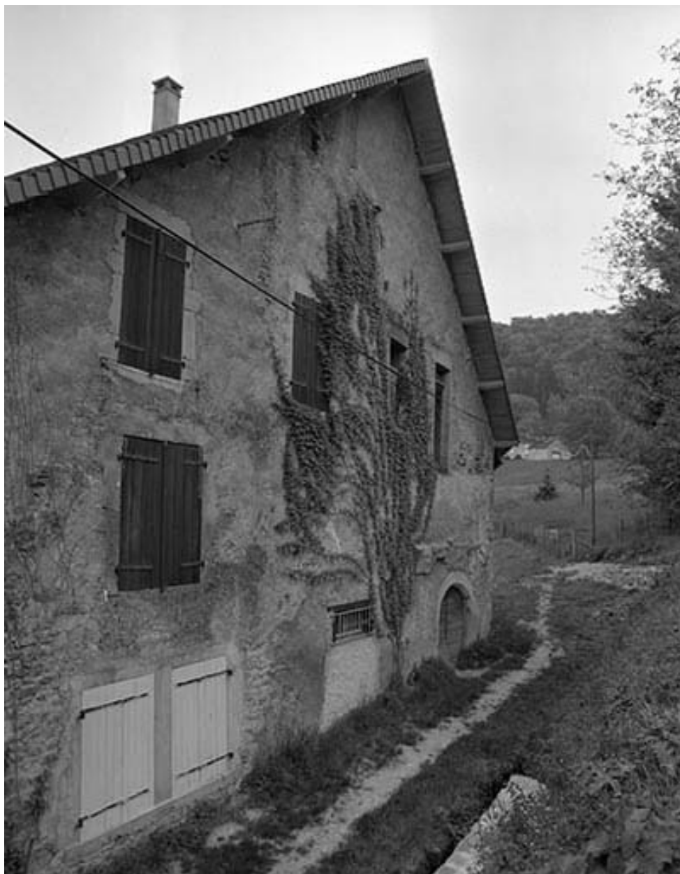
Façade latérale droite.
