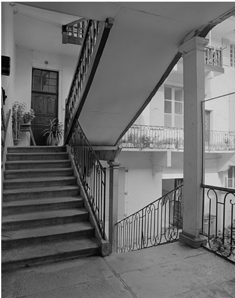
Escalier vu depuis le premier palier.
