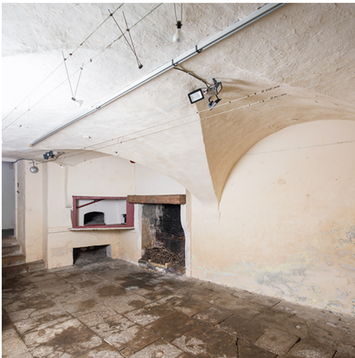
Cellier du rez-de-chaussée, depuis le fond vers le couloir.
