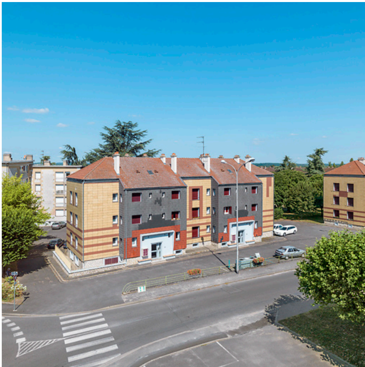
Bâtiment Binot-D, façade antérieure est.
