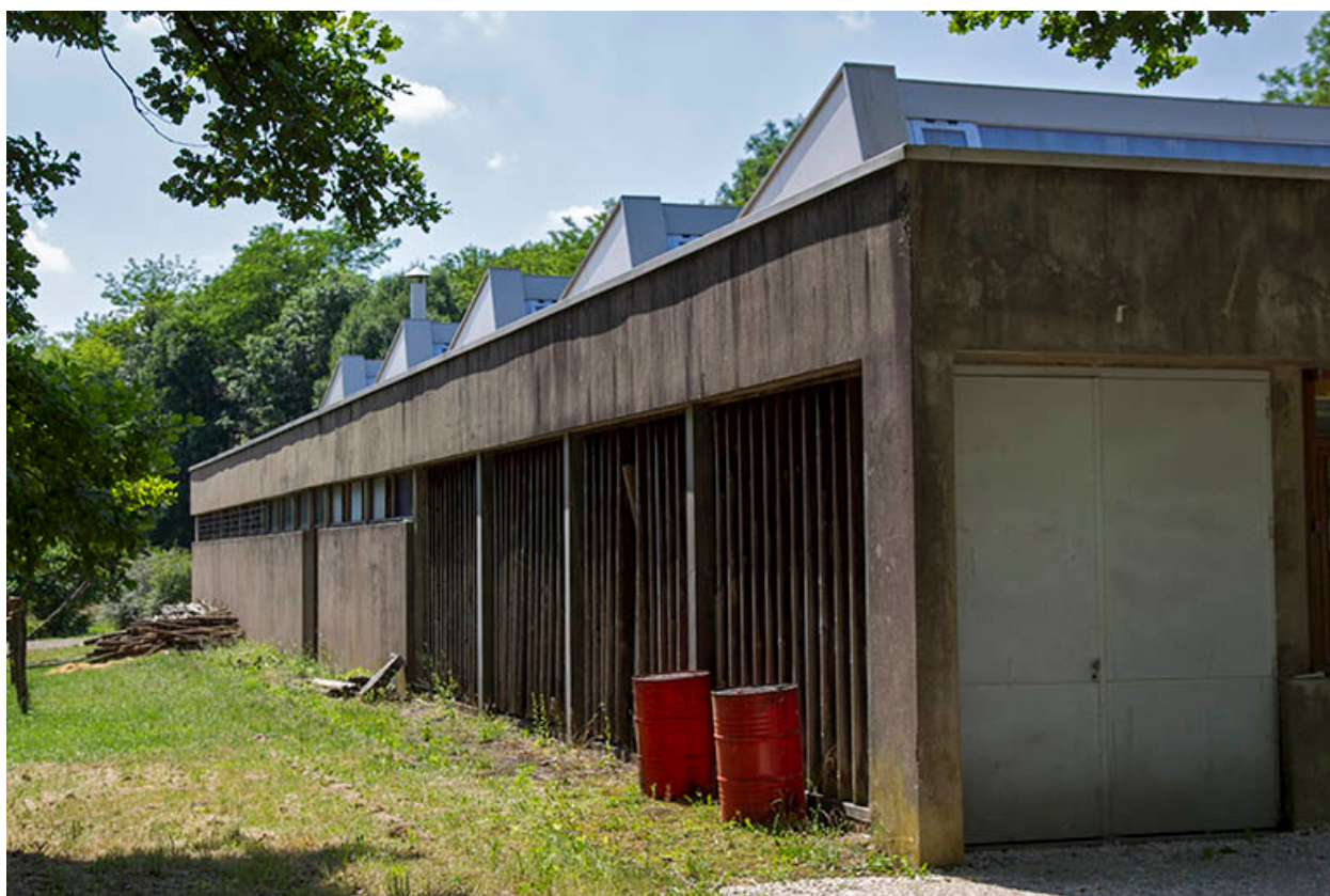
Angle sud-est de l'atelier.
