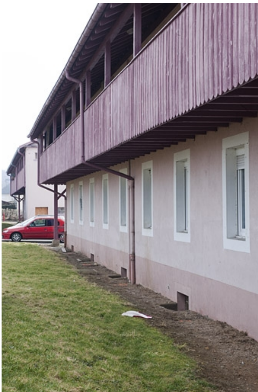
Façade postérieure d'un immeuble d'habitation.
