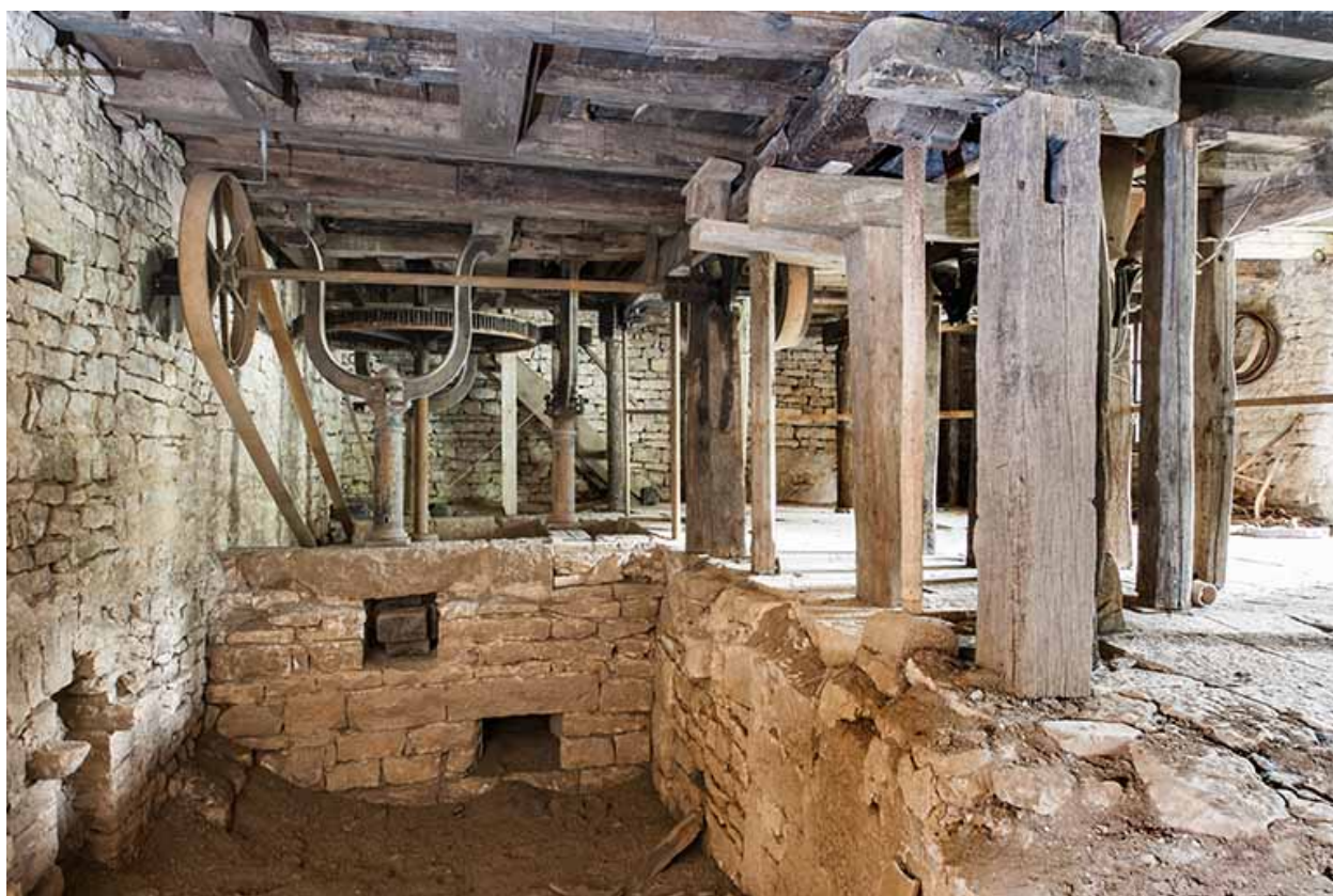
Etage de soubassement. Vue depuis l'ouest.
