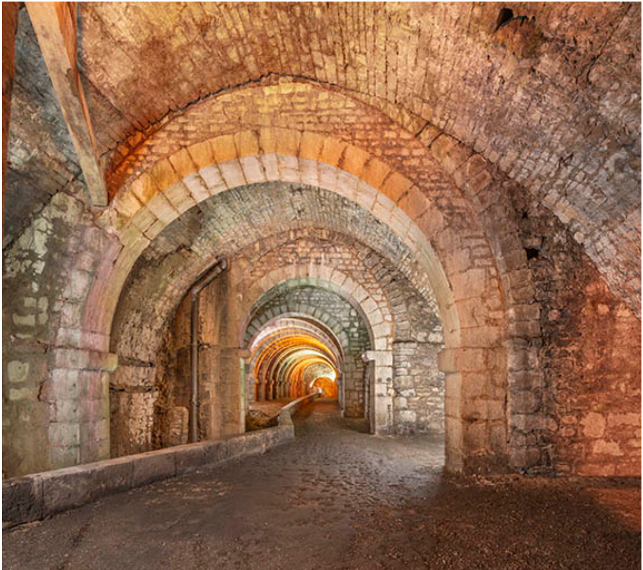
Galerie de communication entre les puits d'Amont et d'Aval (ou à Grès).
