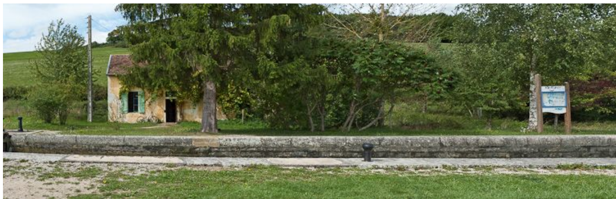
Vue de face de la maison éclusière.
