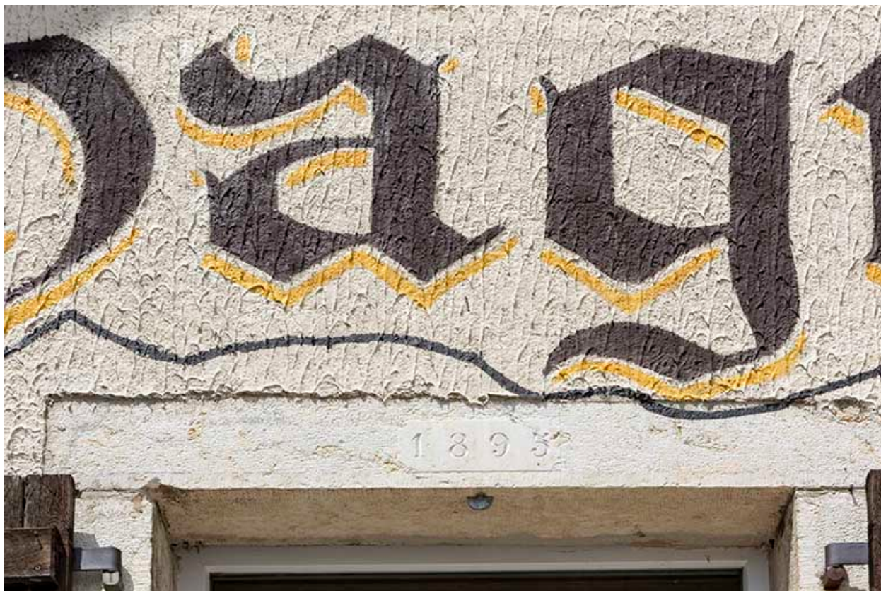
Façade antérieure : linteau daté 1895.
