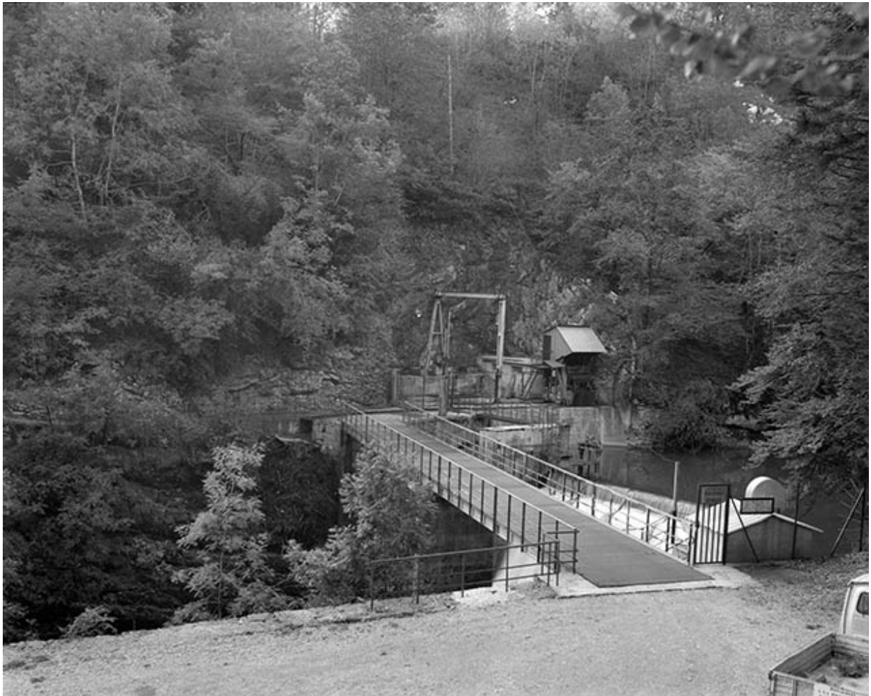
Vue d'ensemble de la prise d'eau.
