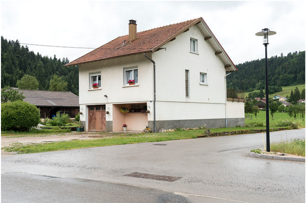
Façades antérieure et latérale droite.
