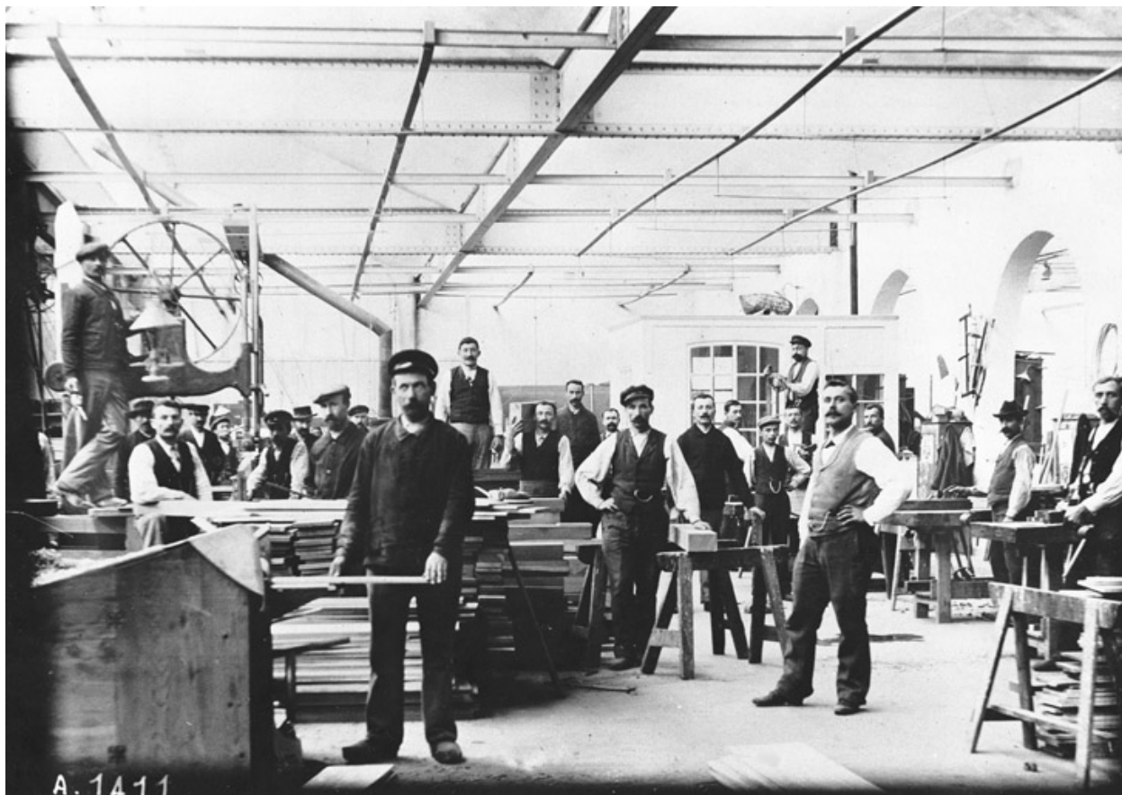
Atelier de menuiserie (carrossage ?). Photogr., s.n., s.d. [vers 1900].
