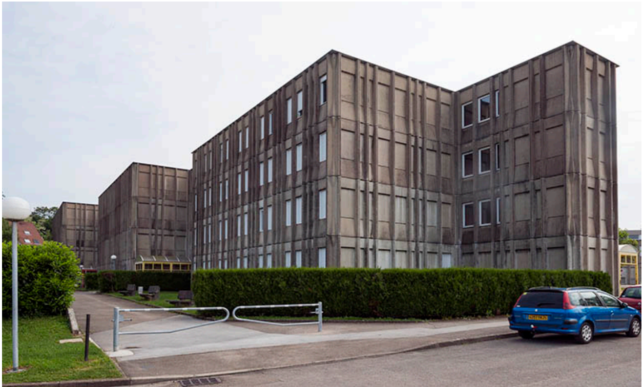
Façade ouest postérieure de l'internat.
