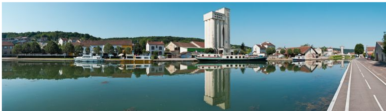
Vue d'ensemble du port de Montbard.
