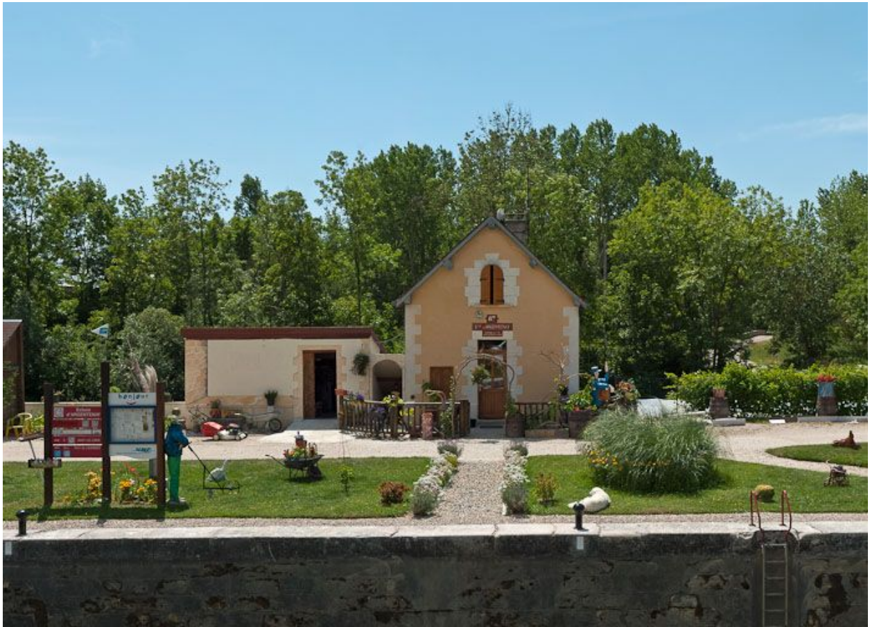
Vue d'ensemble du site d'écluse.
