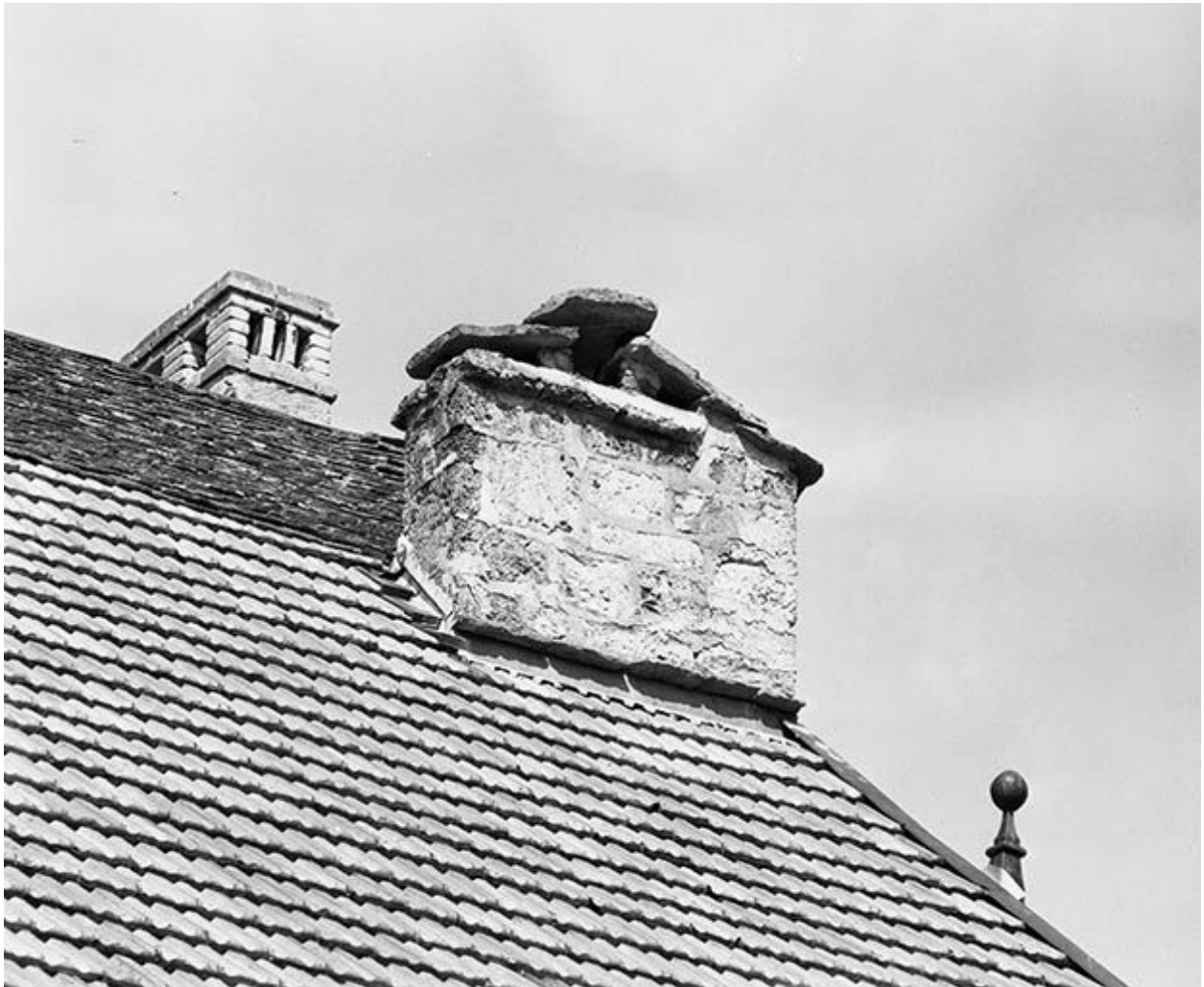
Détail d'une souche de cheminée.
