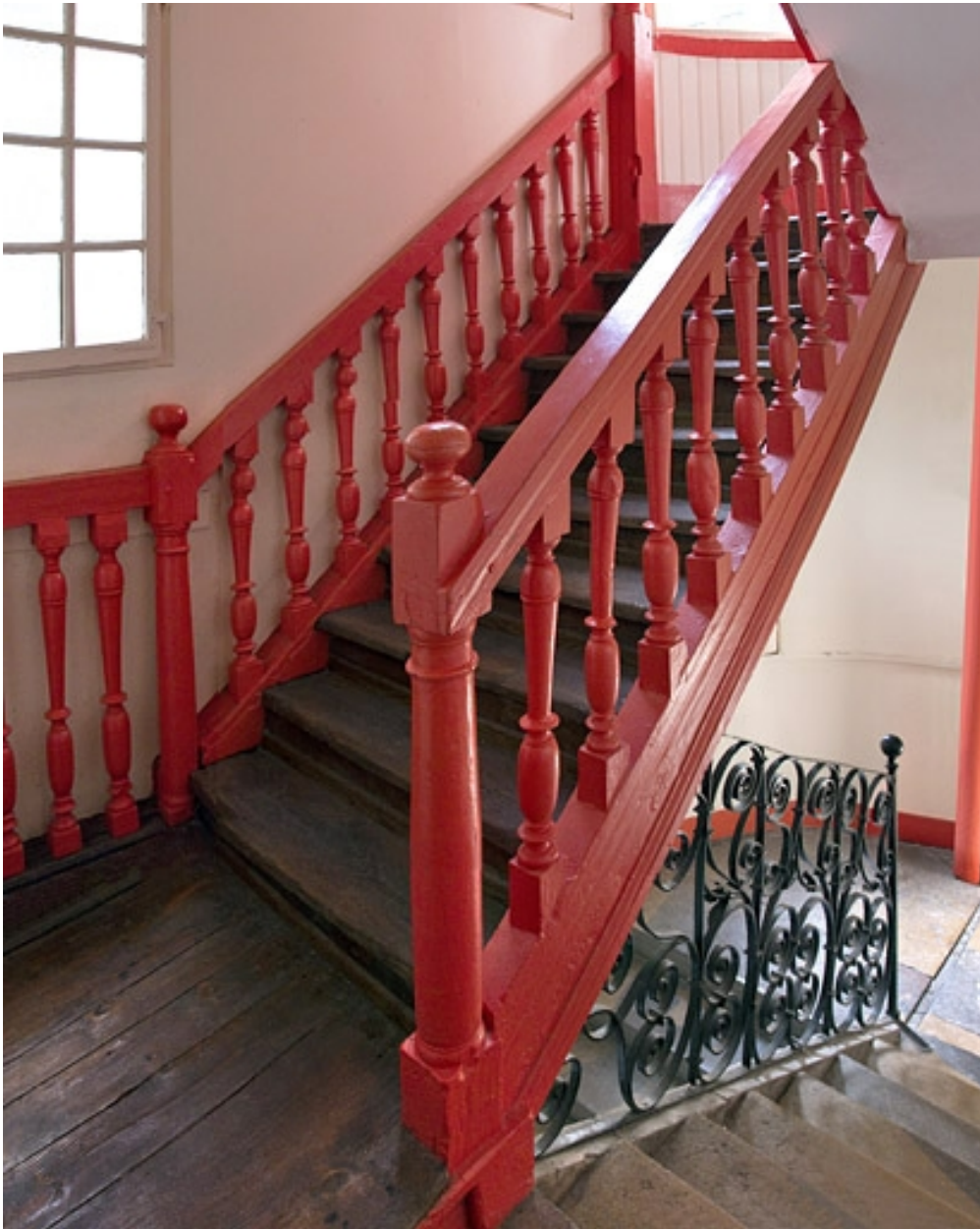
Escalier à cage ouverte : détail de la rampe en ferronnerie, puis à balustres de bois tourné.
