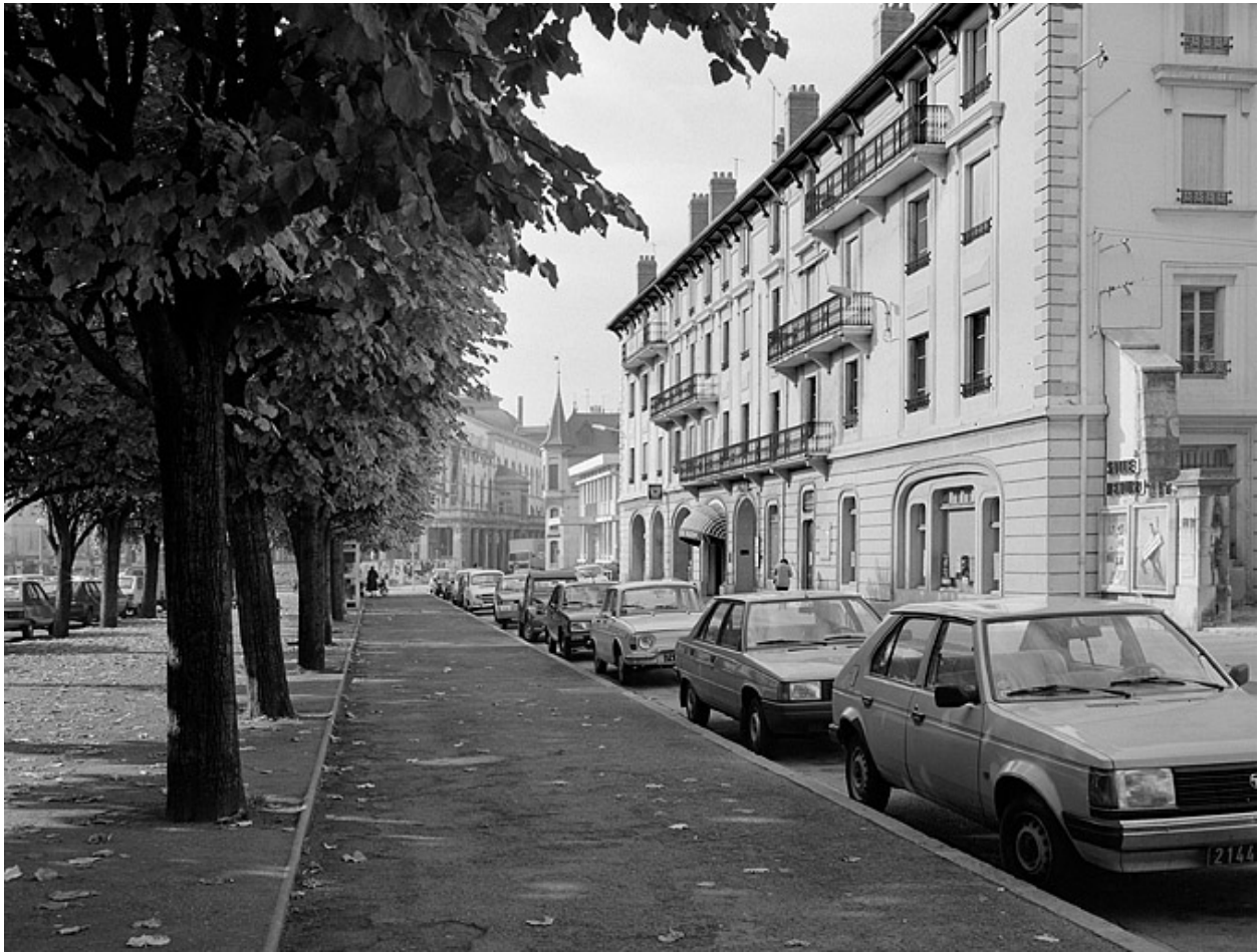
Anciens bâtiments conventuels. Façade sur la rue Pasteur.
