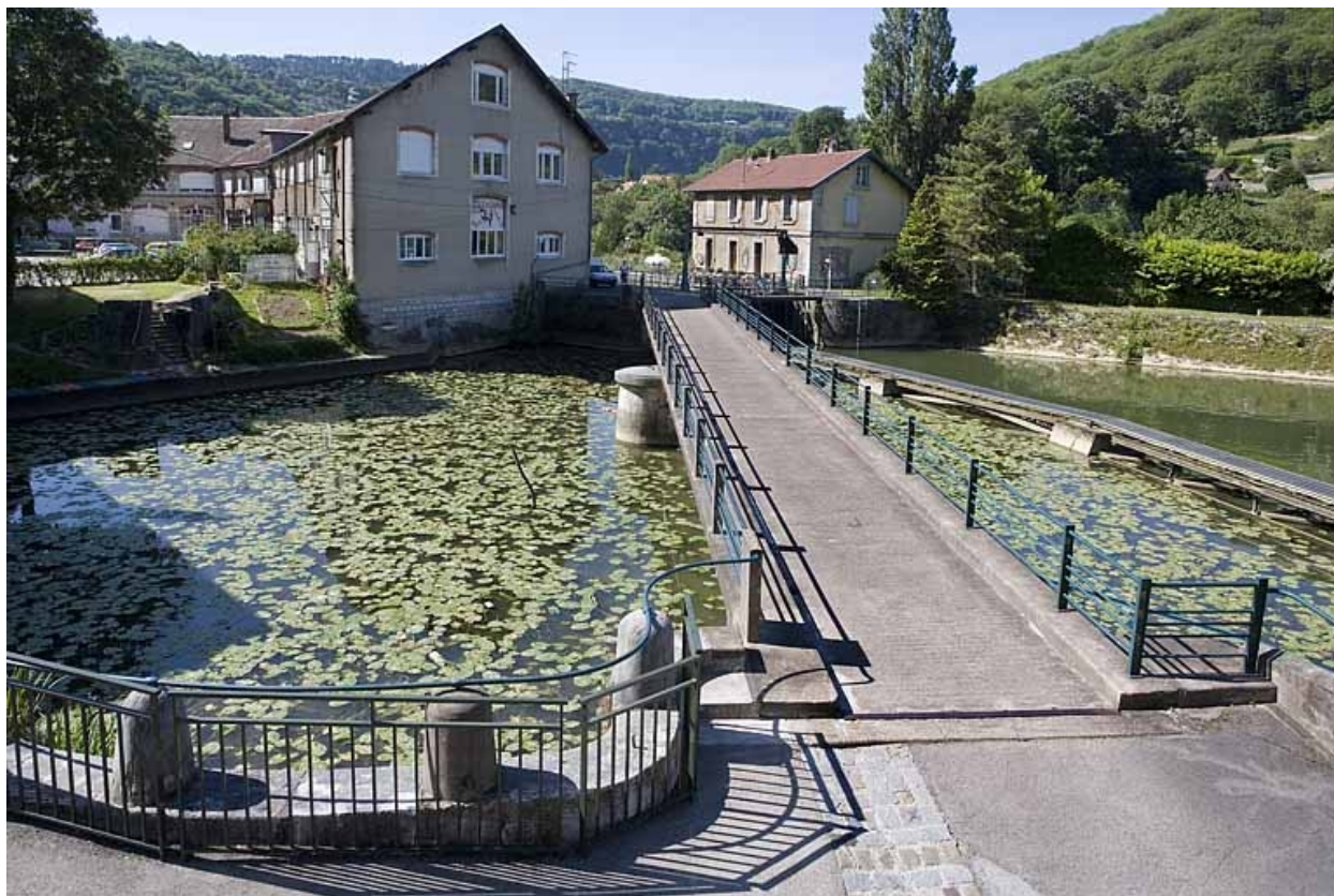
Vue d'ensemble, depuis l'amont.
