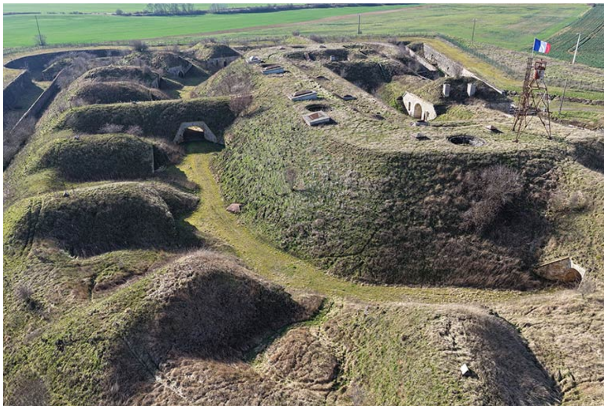
Le fort de Beauregard : les plateformes de tir intercalées entre chaque traverse-abri et la rue des Remparts. (vue aérienne).
