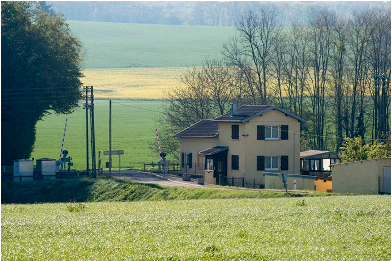
La maison du garde-barrière, vue générale.
