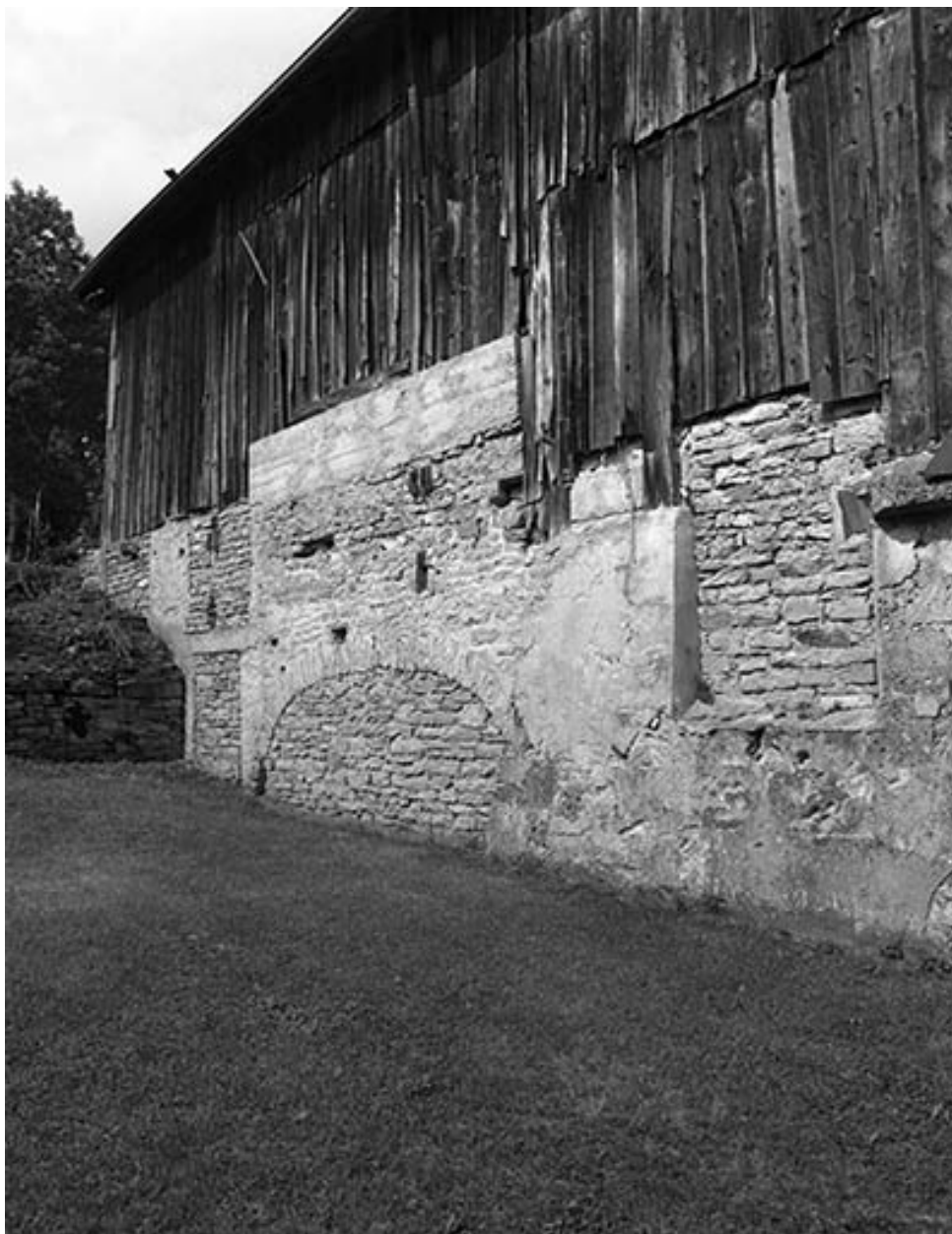
Façade sud de l'atelier de fabrication.
