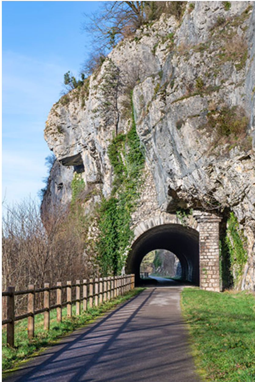
Vue du tunnel depuis l'est.
