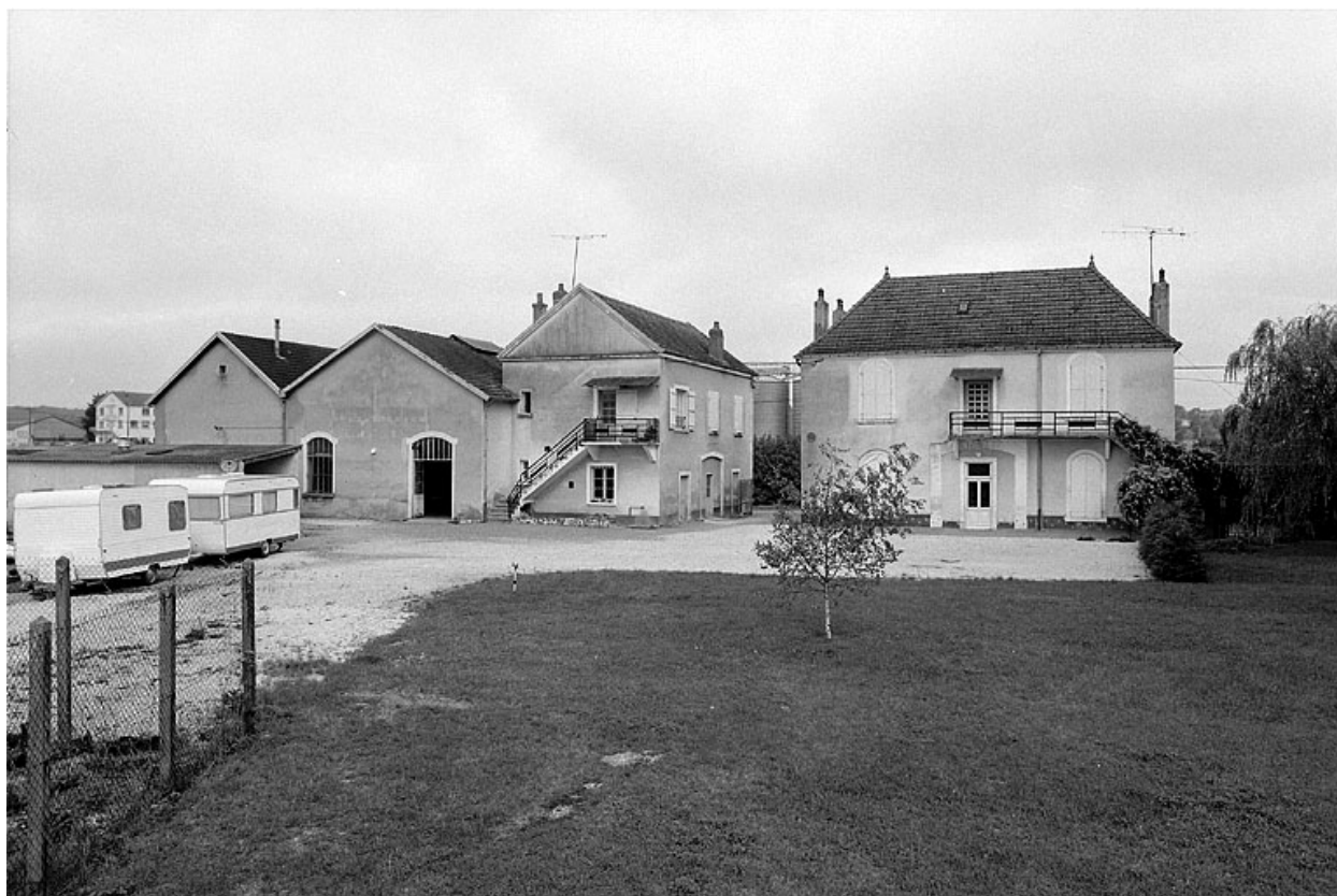
L'usine à gaz : façades postérieures.
