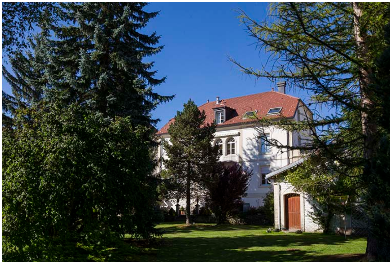
Façade postérieure, dépendance et parc.
