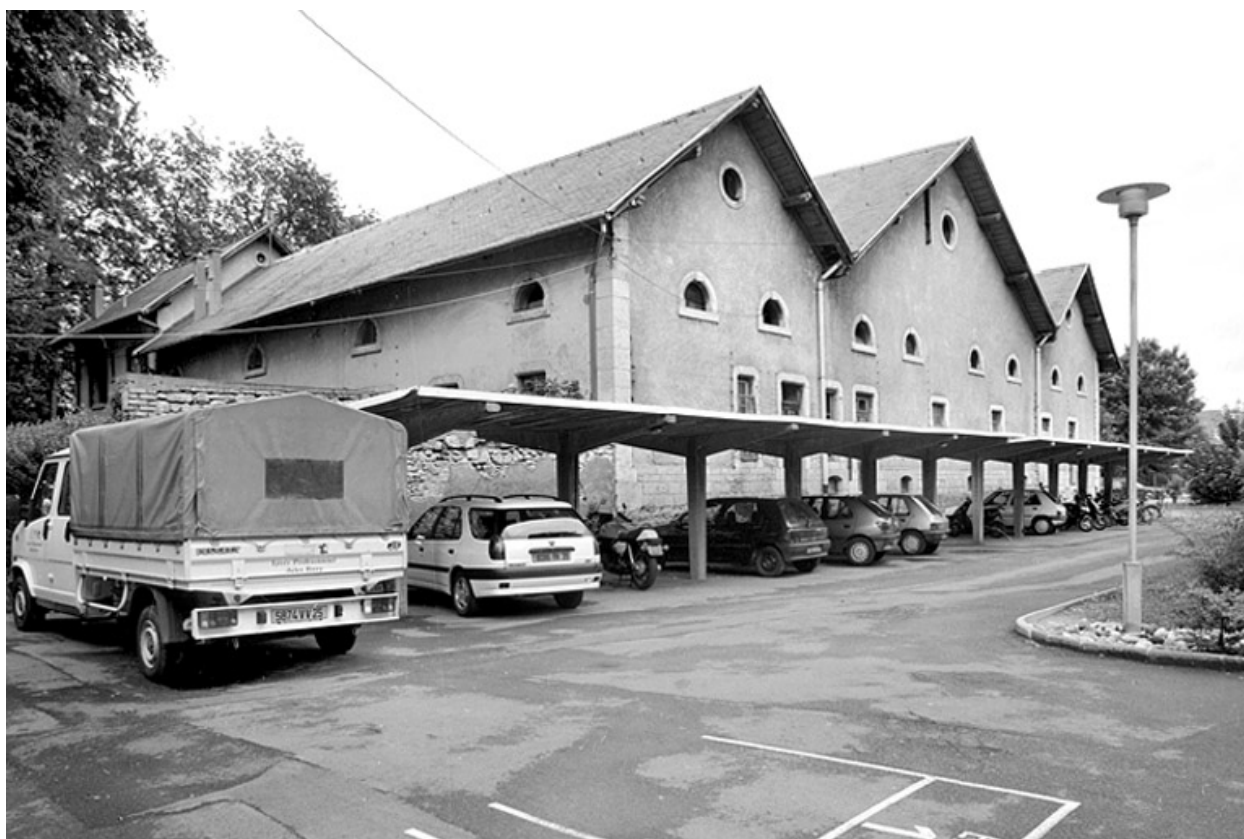
Façade postérieure des écuries.
