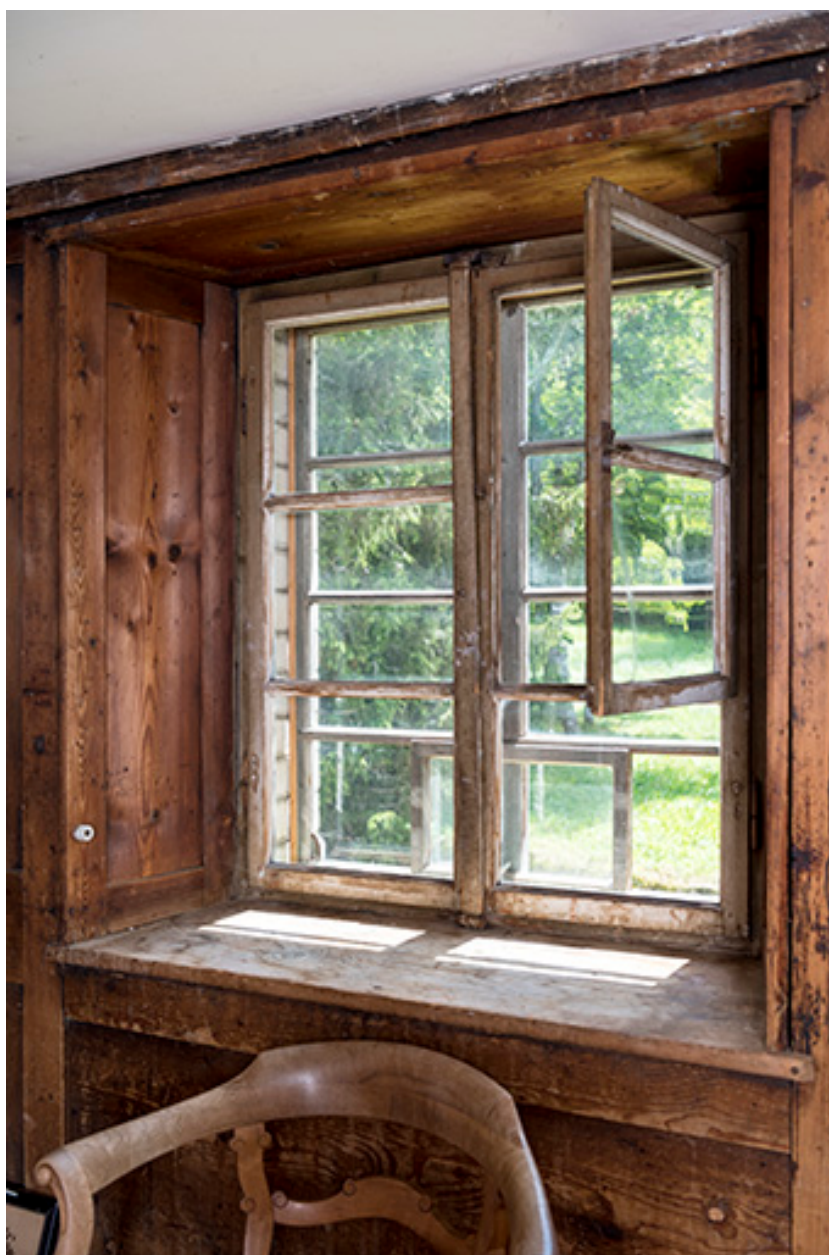
Fenêtre avec deux vitrages.
