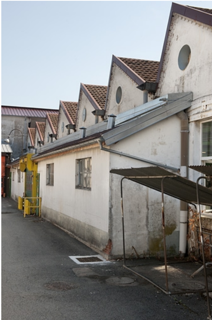
Pignons ouest d'un atelier.
