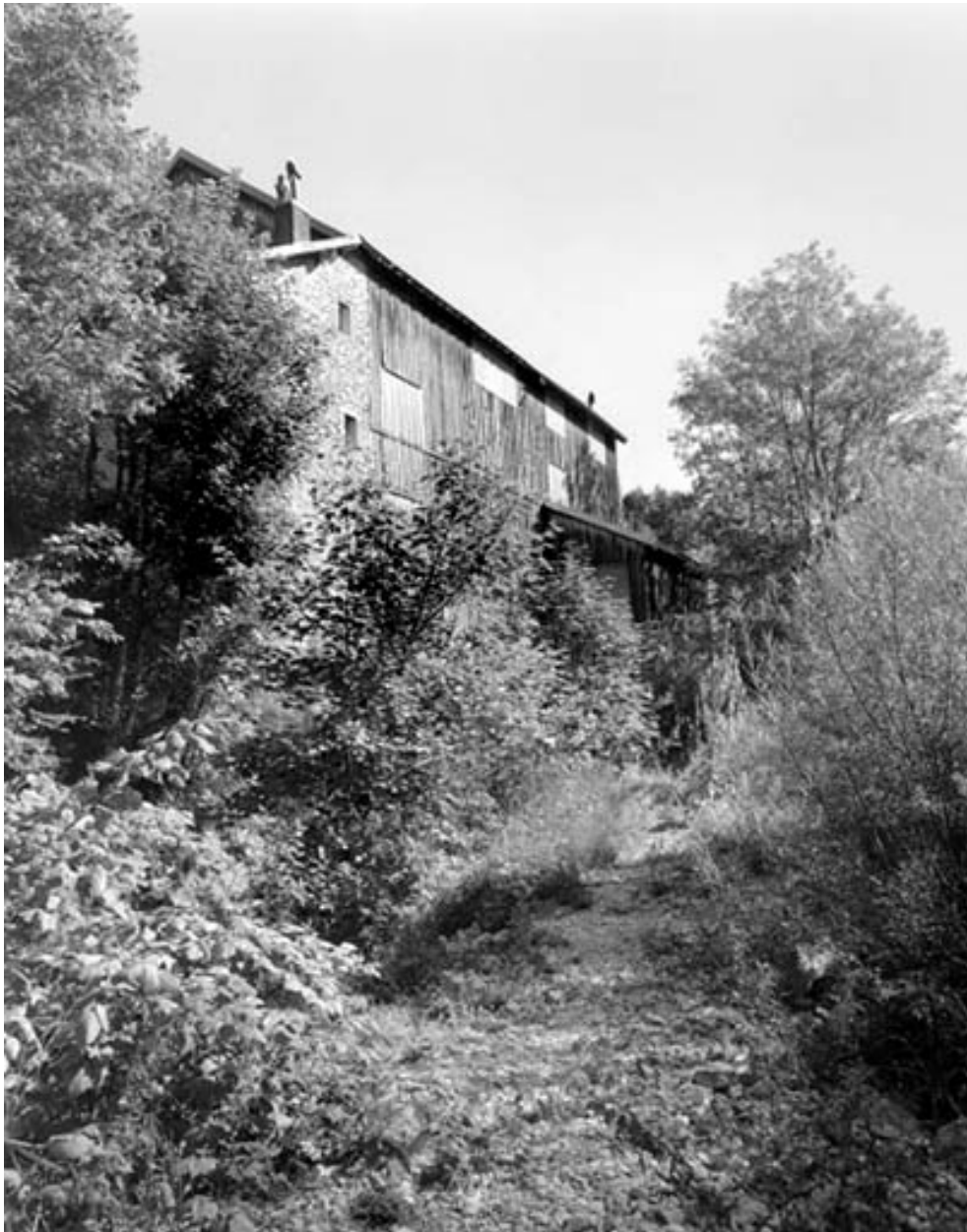
Façade sur l'Ain de l'atelier de fabrication.
