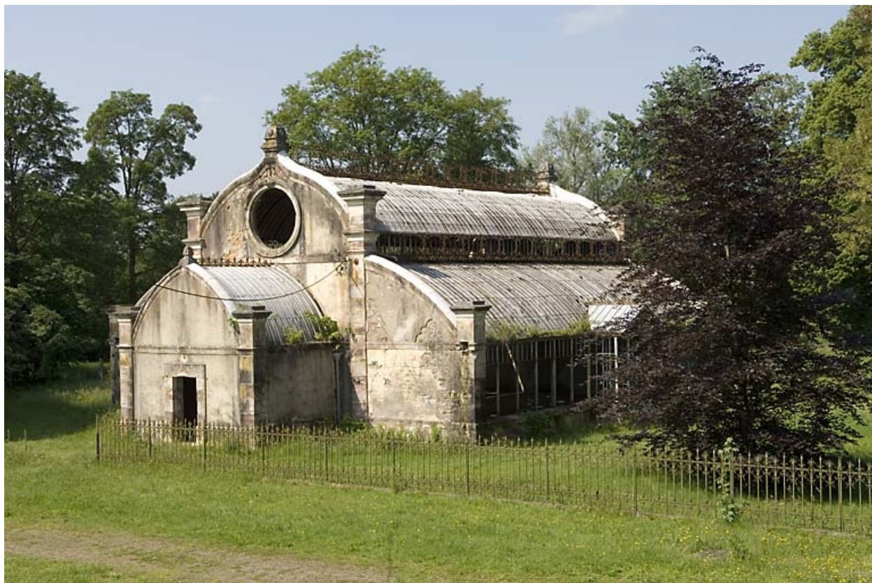
Vue d'ensemble de la serre.
