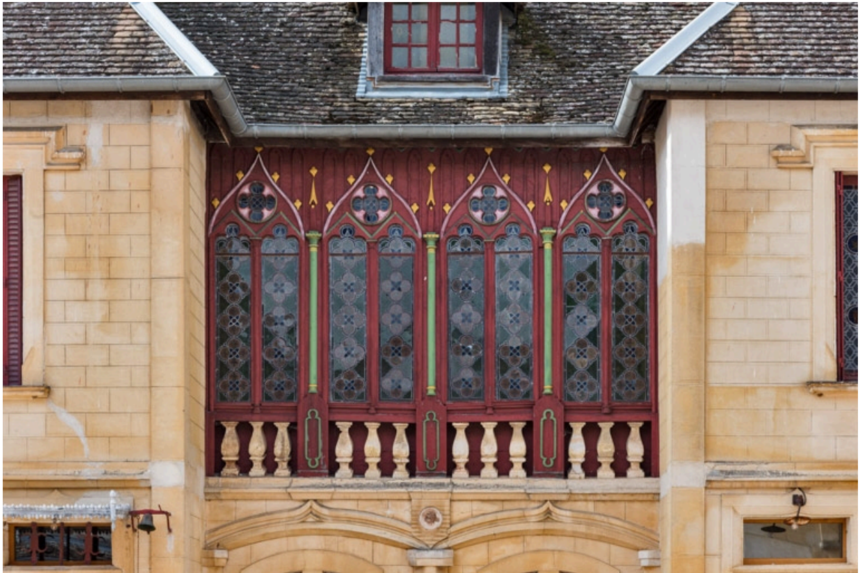
Elévation antérieure : galerie à l'étage.
