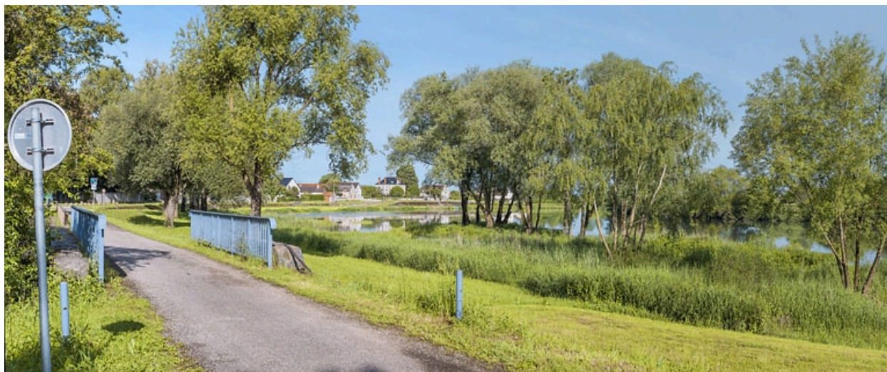
Ponceau supportant le chemin de halage au début de la digue.
