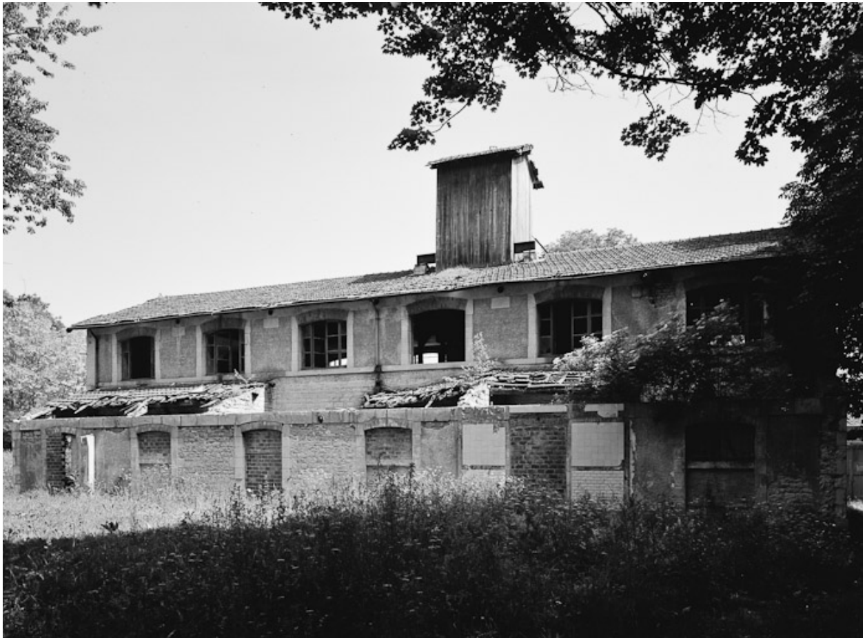
État en 1984, vue depuis le nord.
