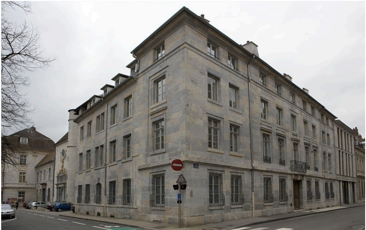
Vue d'angle de l'immeuble.
