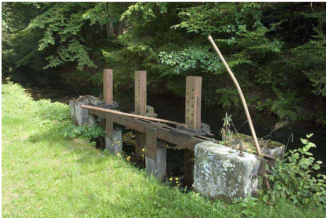
Vanne de décharge sur le bief d'amenée.
