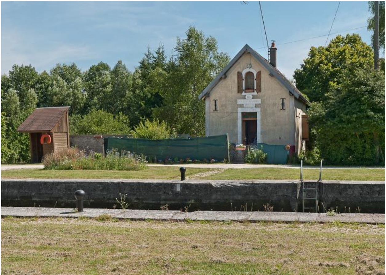
Vue d'ensemble du site d'écluse.
