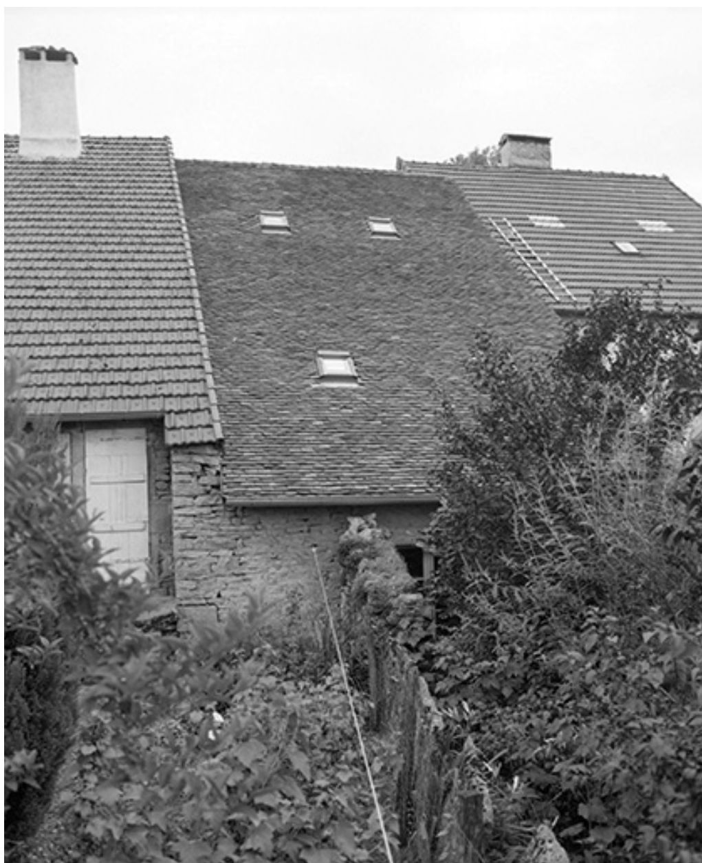
Maisons situées rue de l'Eglise : façades postérieures.
