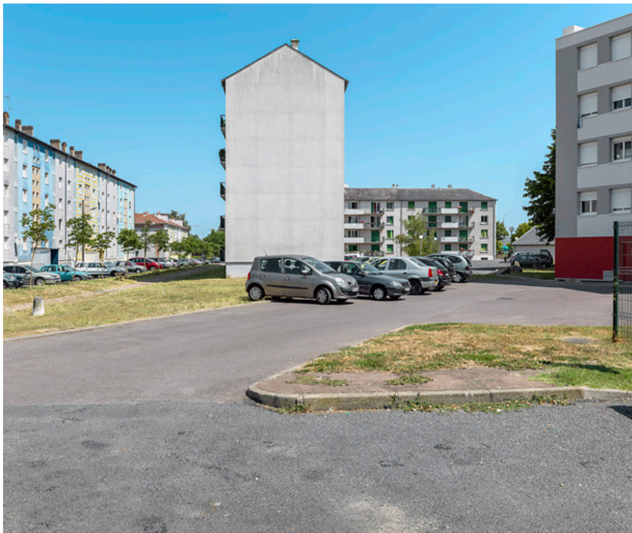
Bâtiment SIDEN, façade latérale sud et façade postérieure sud.
