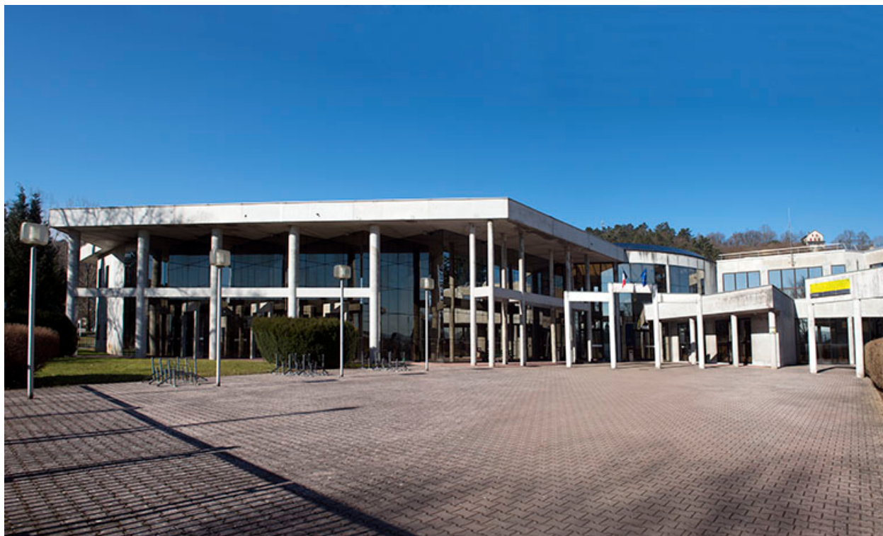
Cour d'accès et entrée depuis l'est.
