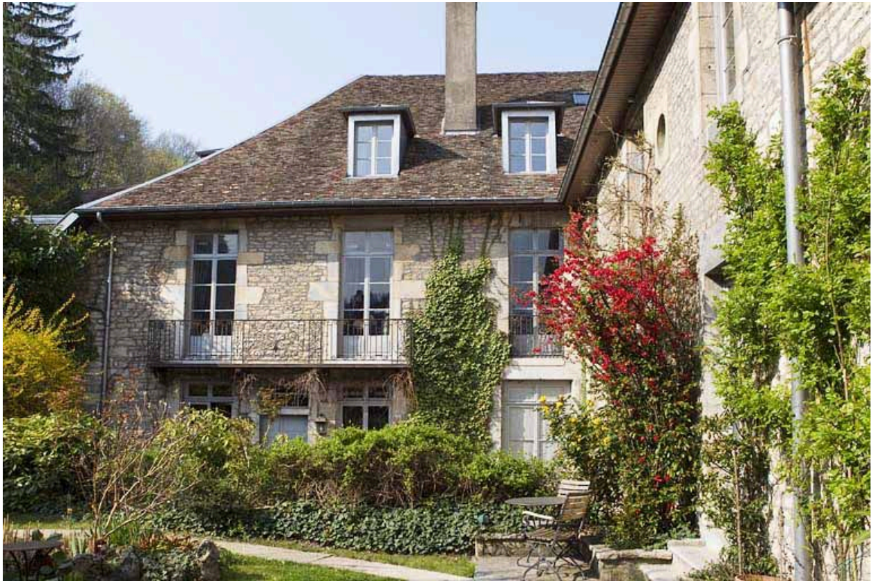
Vue d'ensemble de l'aile sur jardin du logis principal.
