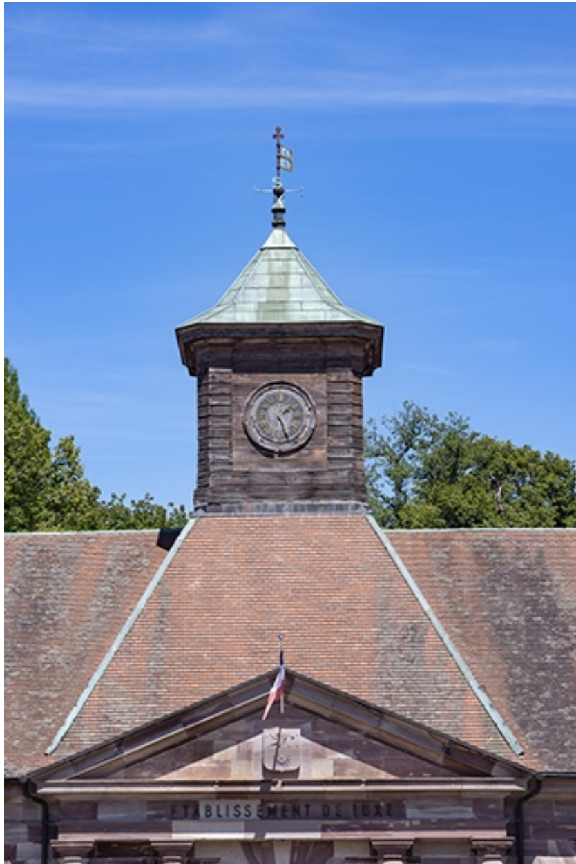
Bâtiment nord dit du Grand Bain, toiture et clocheton.
