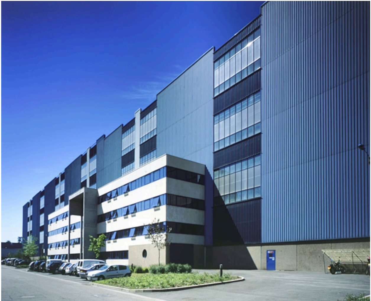
Halle 330 (bureaux et ateliers de montage).
