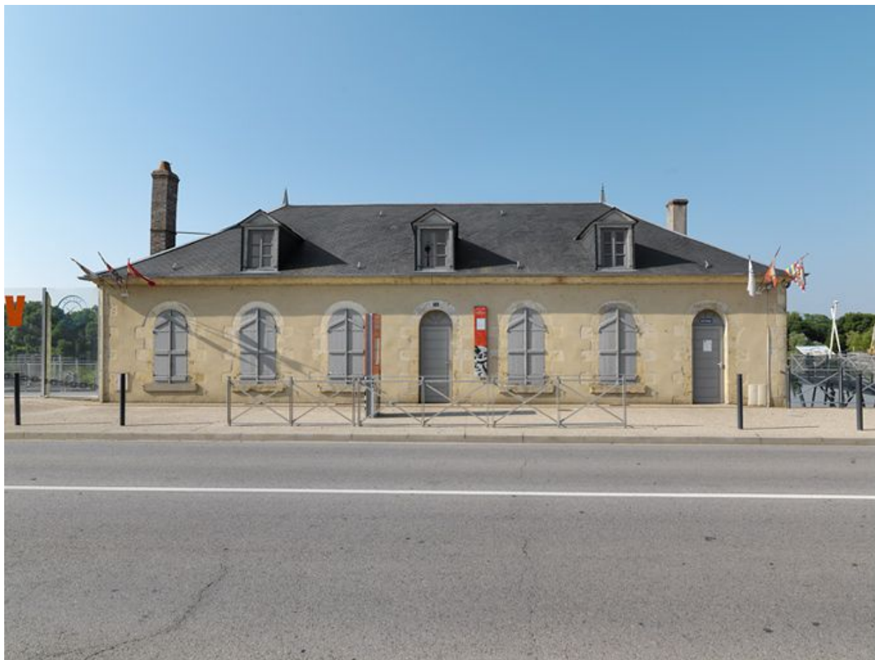
Façade de la maison, côté route.
