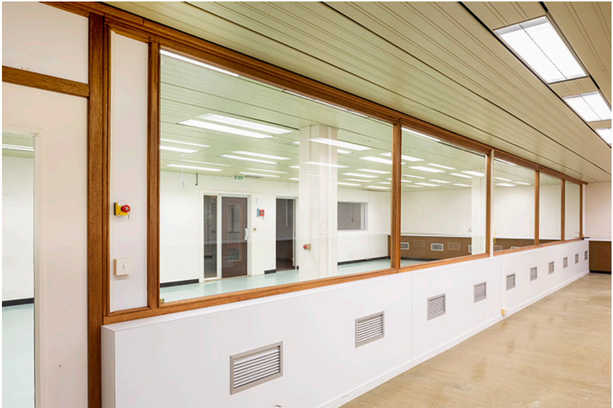
Ancien laboratoire de métrologie, 1er étage de soubassement : salle.
