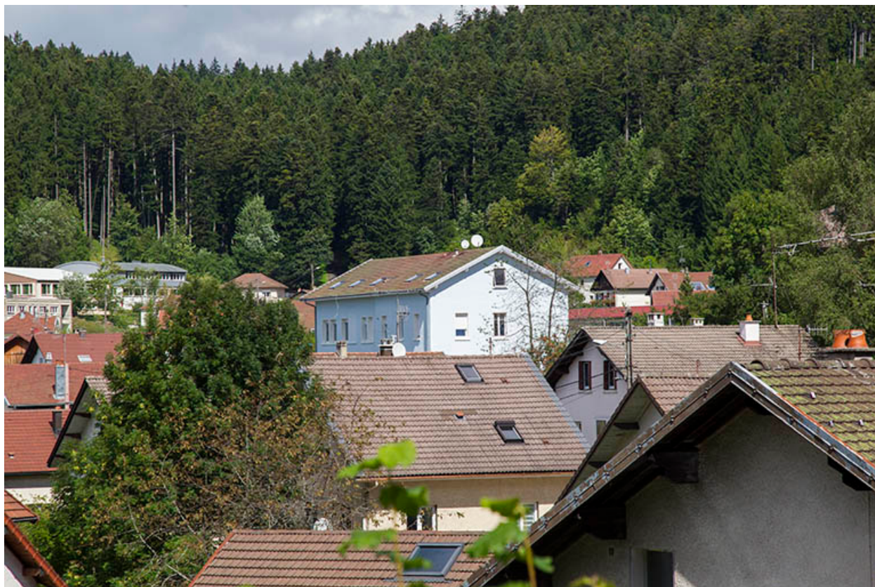
Vue d'ensemble éloignée, depuis le sud.
