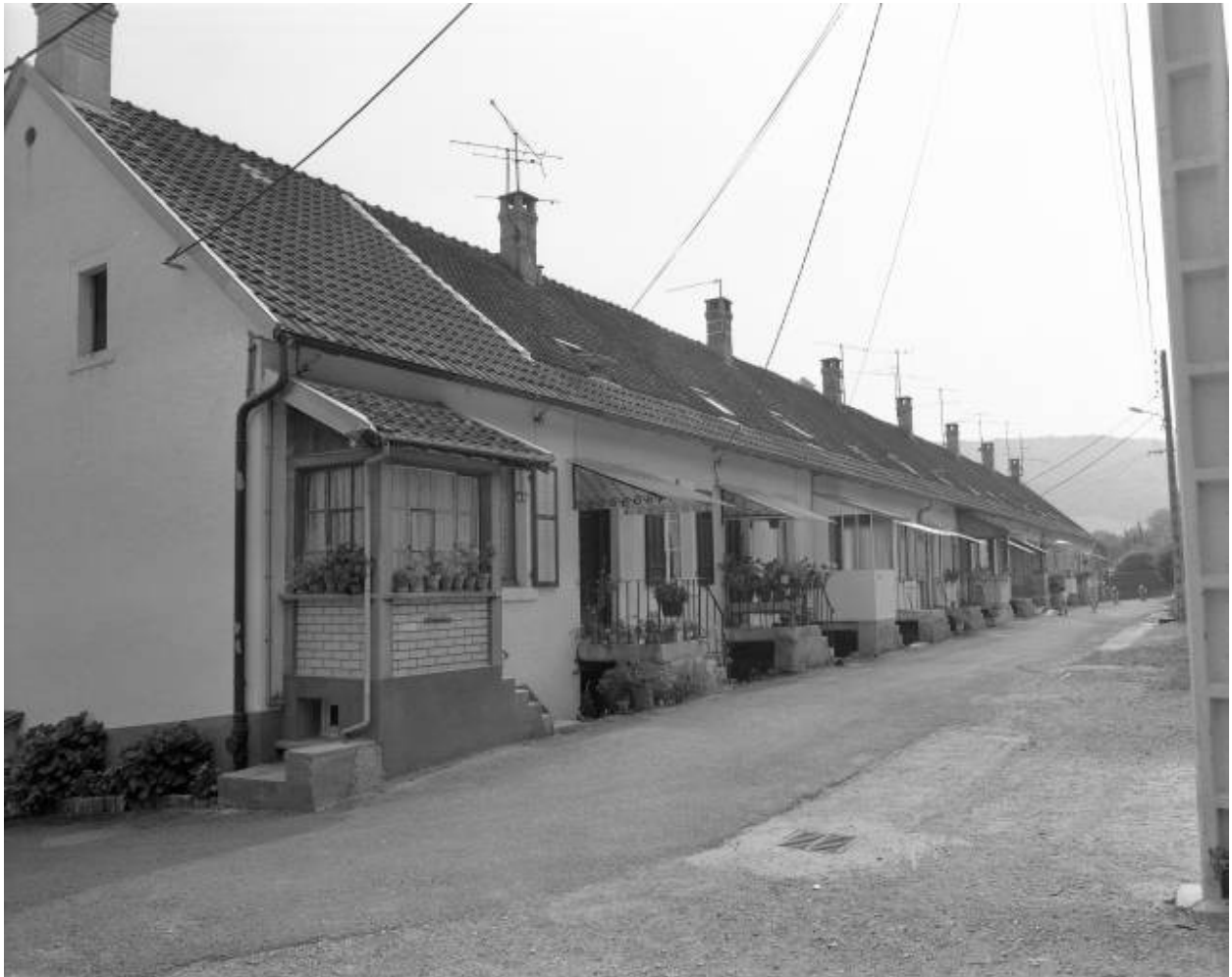
Logement ouvrier. Façade postérieure en 1981.
