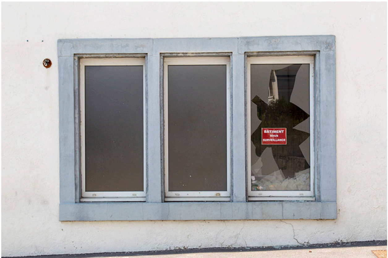
Usine, 1er corps de bâtiment : fenêtre multiple sur la façade antérieure.
