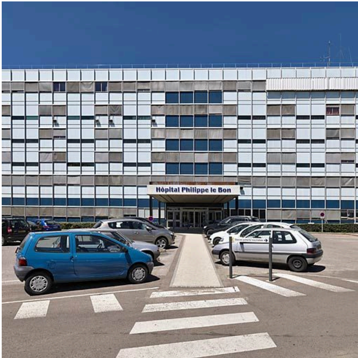
Bâtiment principal, partie centrale de la façade.
