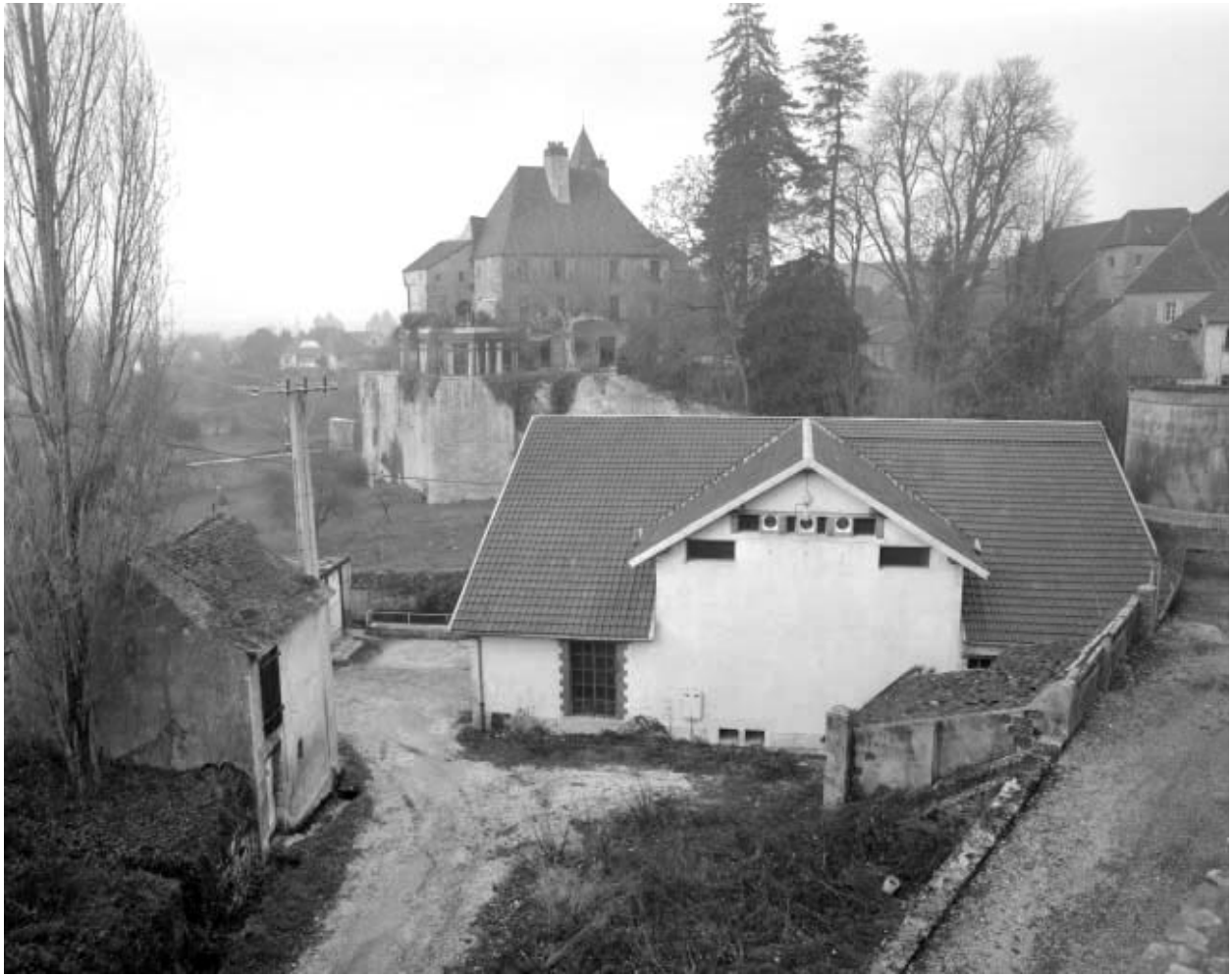
Vue plongeante sur la centrale.
